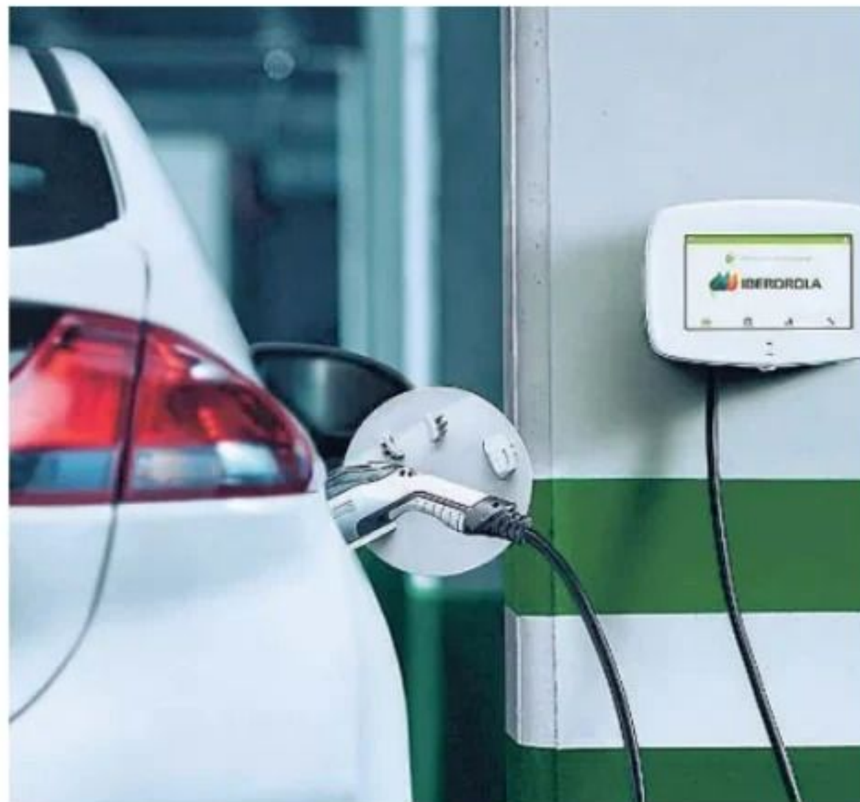
Un punto de recarga de Iberdrola en Madrid
